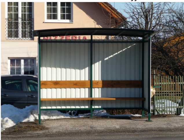
Obnovená čakáreň SAD na Majeri
